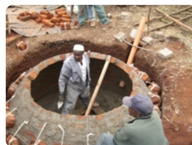
Bau von Biogasanlagen für Haushalte in Kenia
